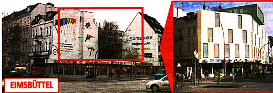
Osterstraße, Ecke Schulweg: Dort, wo jetzt die Lücke klafft, könnte über dem Laden einmal ein Wohnhaus oder Bürogebäude stehen
